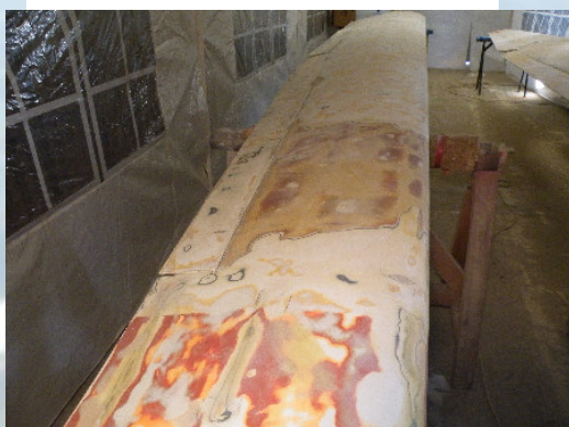
1) Ponçage, à la main, pour éliminer les couches non adhérentes et régulariser la surface.
