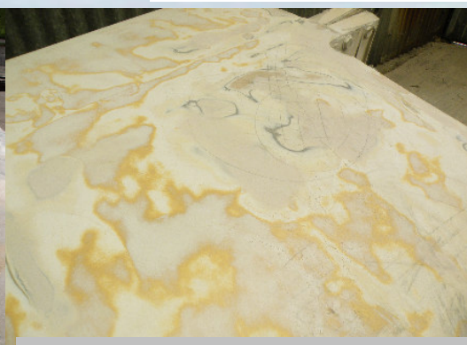
3) Rebouchage primaire aux microballons + résine époxy ; on voit les coups de crayons servant de guides, utiles pour le ponçage manuel.
