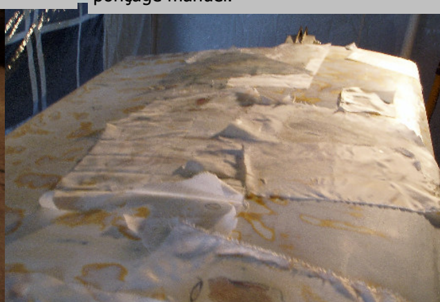
5) Pose de fibre + résine sur les zones fragilisées ou en creux ; le tissu d'arrachage permet d'enlever l'excédent de résine.
